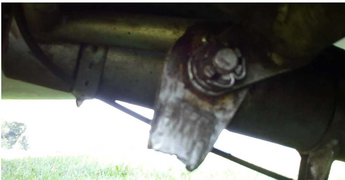
Obr. 3 – část prasklé vzpěry ovládání podvozku v místě změny jejího průřezu.
