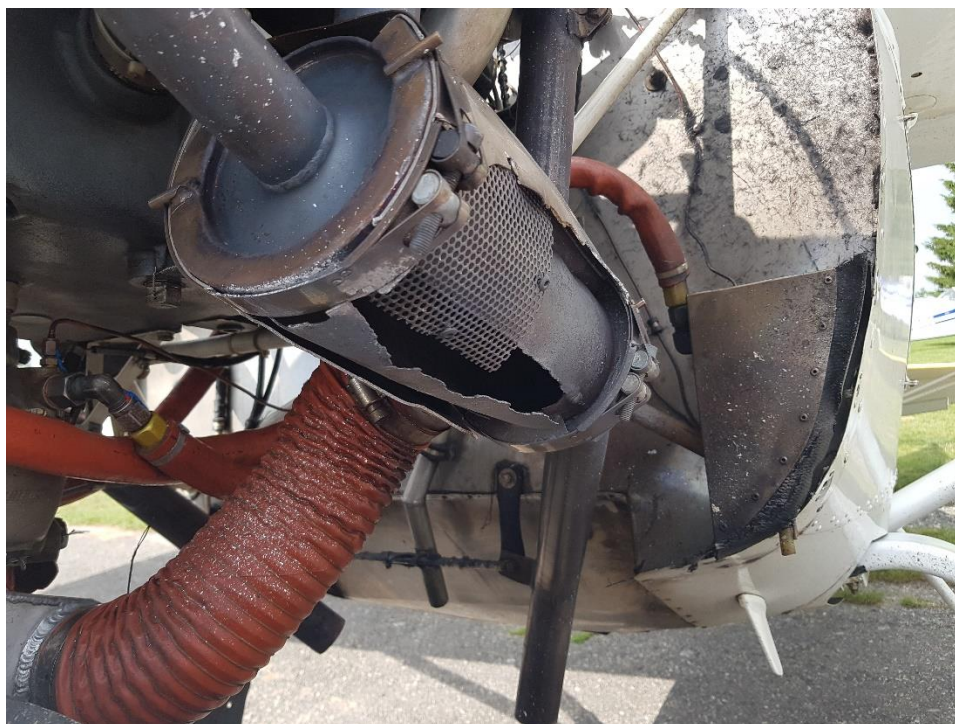
Obr. 3: Propálený výfuk s poškozeným tepelným výměníkem.
