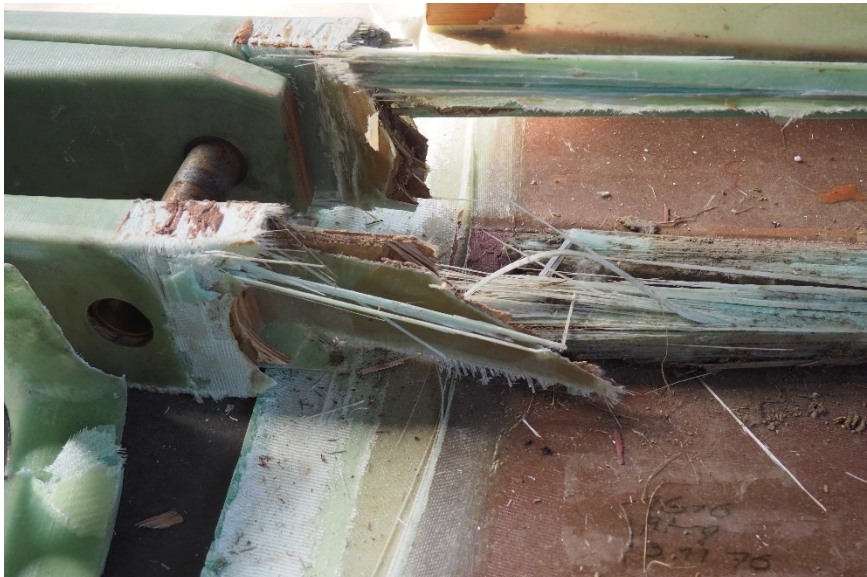
Obrázek č. 14. Detail lomu pásnic a stojiny hlavního nosníku pravé poloviny křídla
