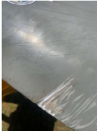
Obr. 11 – Poškození listu vrtule
