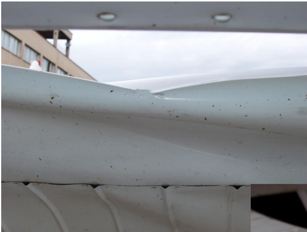
Deformace náběžné hrany klapky při pohledu z předu
