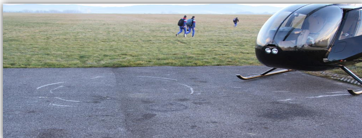
Obr. č. 3: Povrch stojánky u čerpací stanice LPH
