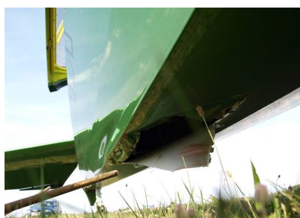
Poškozený potah trupu konstrukcí pomezí značky
