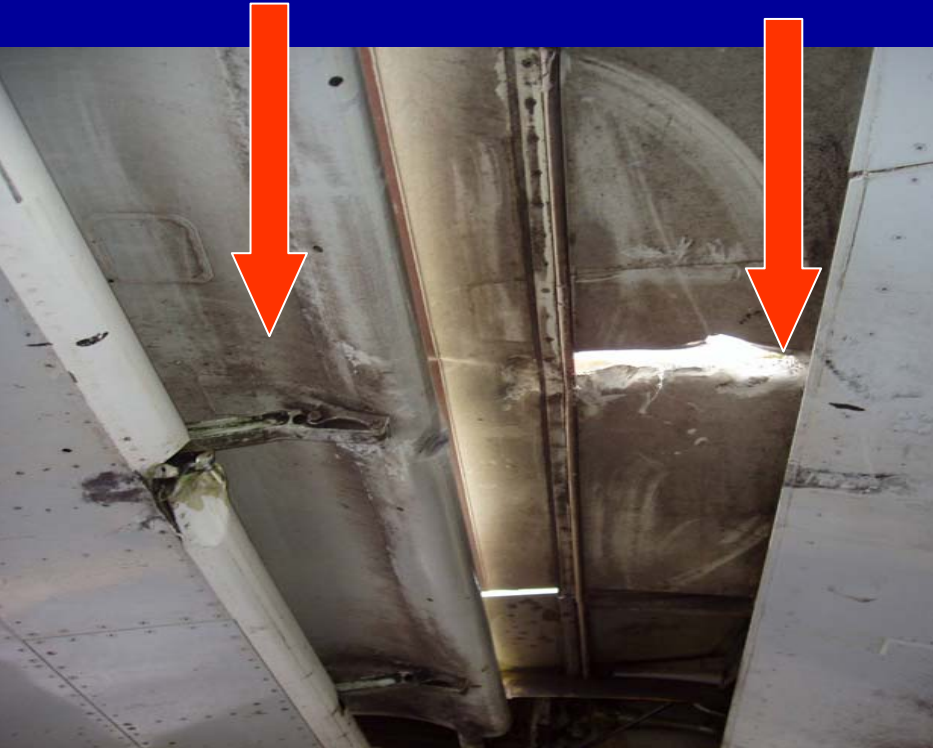
Poškození spoileru a klapek
