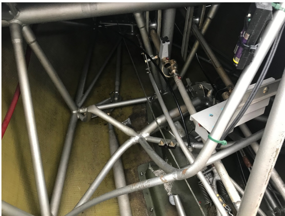
Obr. 2 – Poškození vnitřní trubkové konstrukce trupu.
