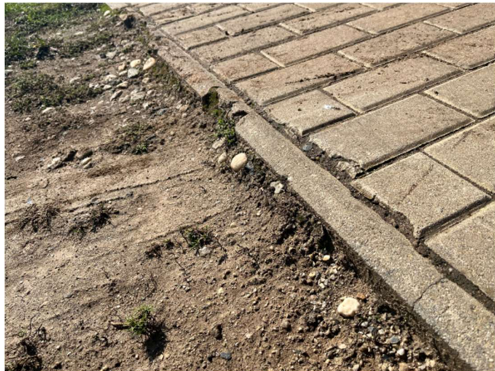
Obr. č.2 – Místo nájezdu na zpevněnou plochu
