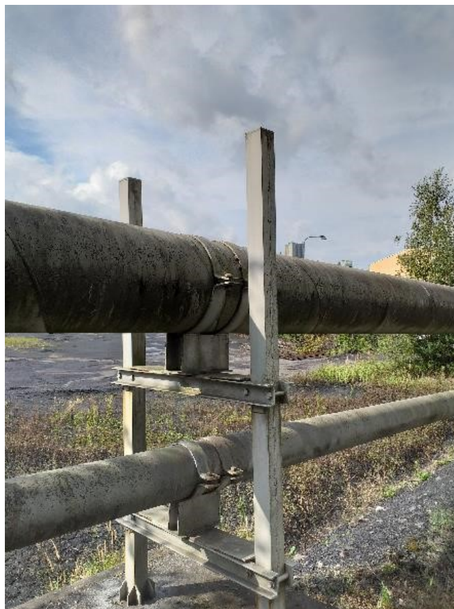
Obr. č. 12 – Ocelový nosník nadzemního potrubí
