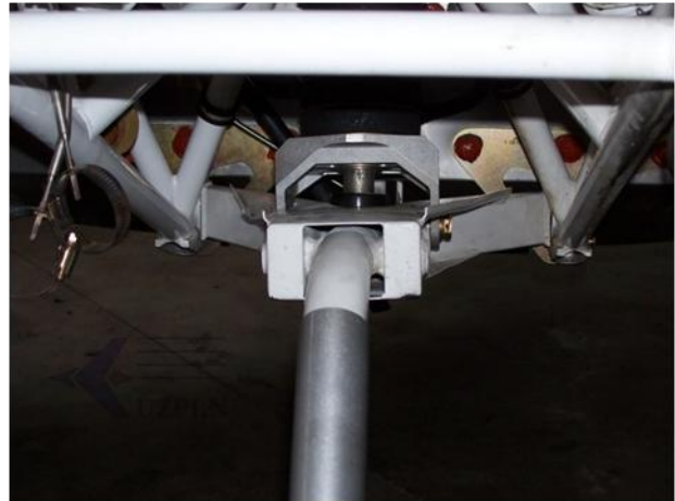
Obr. 4 Poškozený závěs předového podvozku
