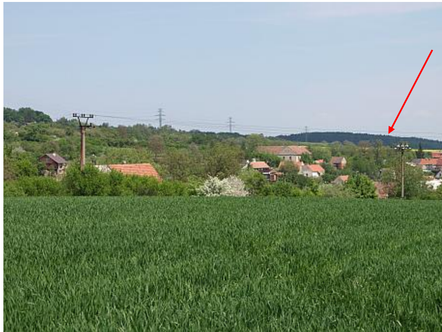
Místo kontaktu balónu s vedením 22 kV.
